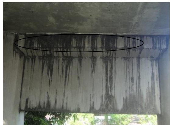
Figura 16. Efeito da eflorescência na passarela 7.
